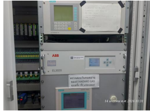
รูปที่ ช.2-1 ระบบตรวจสอบคุณภาพอากาศจากปล่องแบบต่อเนื่อง (CEMS)
