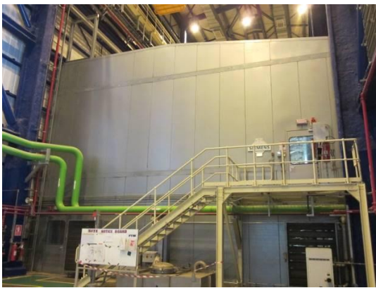
รูปที่ ข.3-1 การติดตั้งชุดลดเสียง (Silencer)
