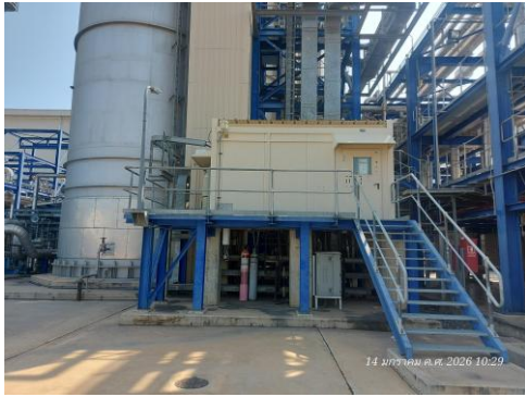
รูปที่ ช.2-1 ระบบตรวจสอบคุณภาพอากาศจากปล่องแบบต่อเนื่อง (CEMS)
